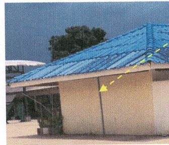
รูปแสดงบ่อเกรอะมีท่อระบายอากาศ
